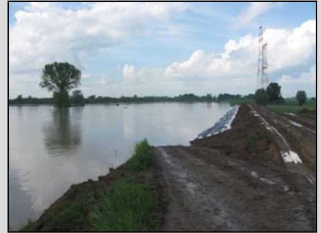
Zalana śluza przy słupach wysokiego napięcia (CL)
