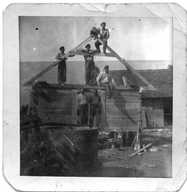
Budowa drewnianego domu na Rudkach
