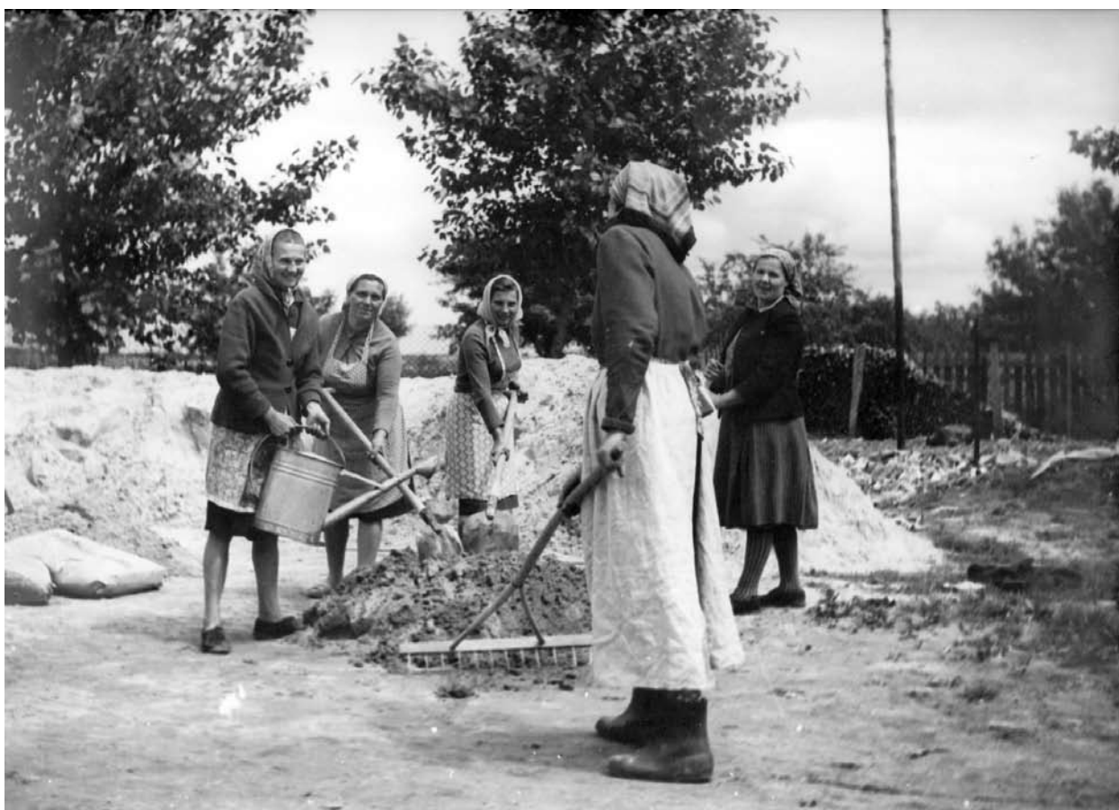
Czyn społeczny kobiet w latach pięćdziesiątych – budowa szkoły. Pracują między innymi: Krystyna Osiak, Katarzyna Wydra, Sabina Sułek, Stanisława Pogoda
